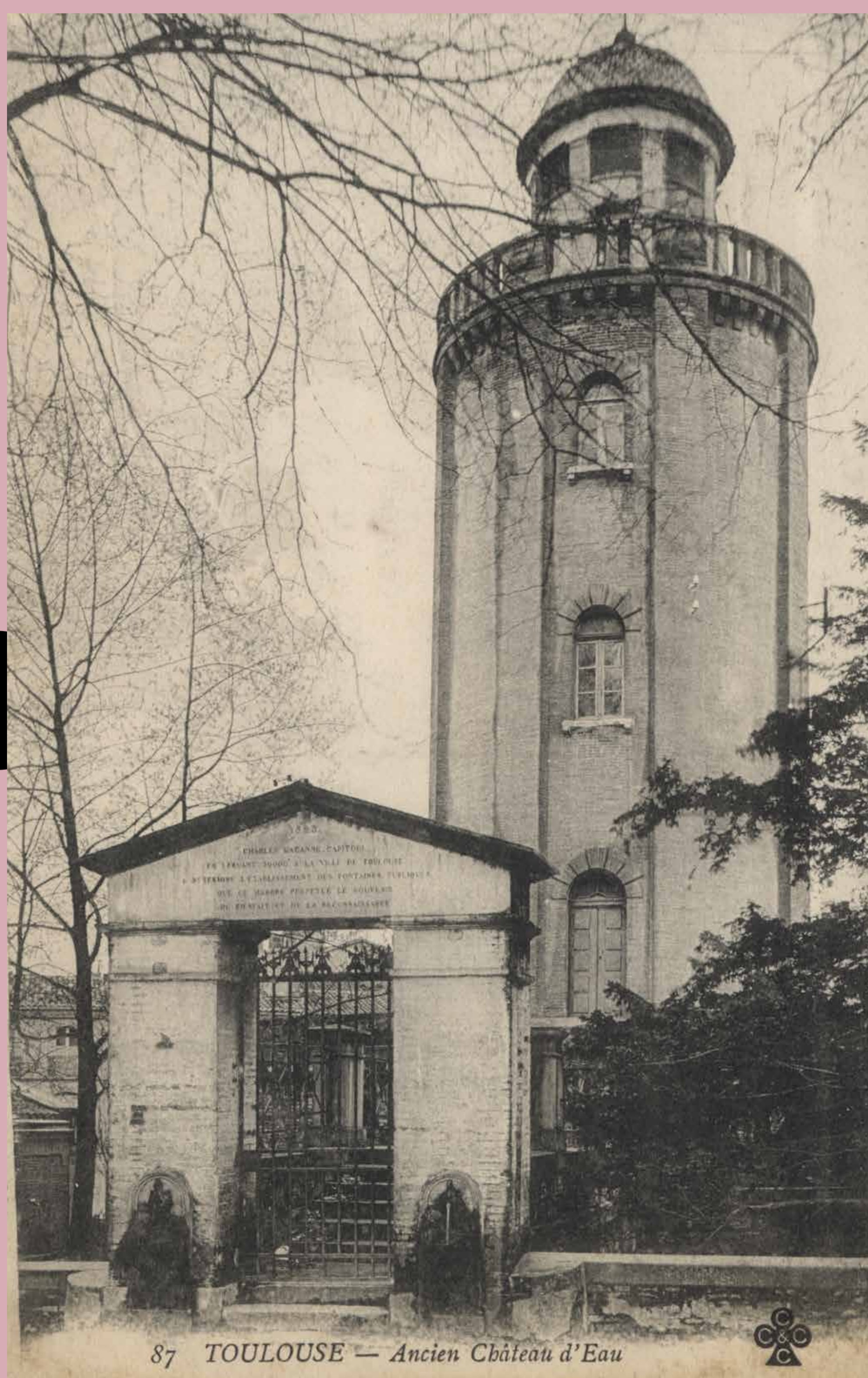
Château d'eau, place Laganne, vers 1910.
